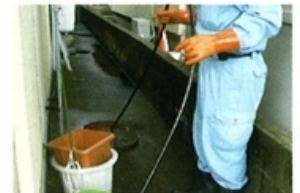
高圧洗浄機にて排水パイプ内清掃中
