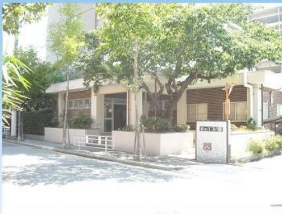
マンションエントランス外観
