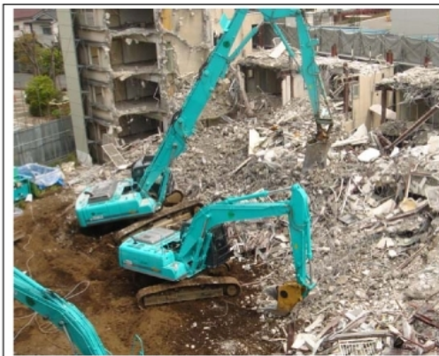
千葉県営作草部団地解体工事解体状況
