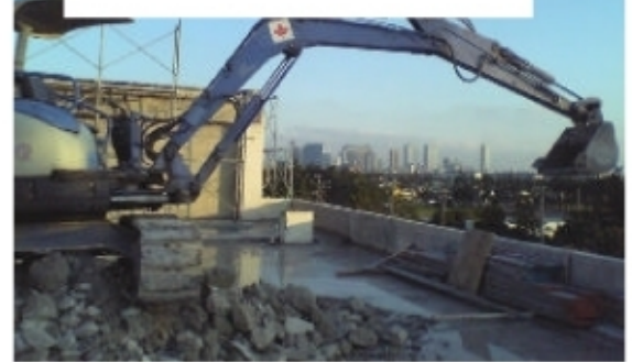
習志野三中4階のみ解体状況 後ろは幕張副都心ビル群
