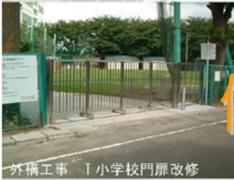
外構工事 T 小学校門扉改修
