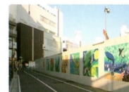
1AP 戸塚アートプロジェクト支援 1/施工
