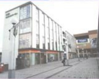
(新都市センタービル外観)
