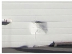
外壁破損
