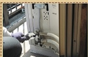
エアコンの取り付け 取り外し
