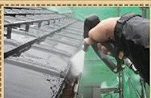
雨どいの清掃 修理作業
